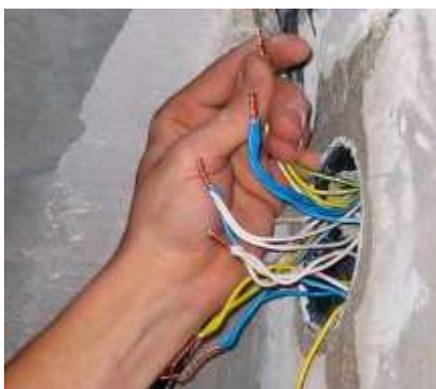
**Рисунок 4 - Вид на ответвительную коробку встраиваемого типа для скрытой электропроводки.**
